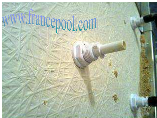
Dévisser l'écrou et déposer le jet air.
